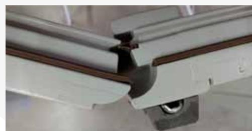
Les menuiseries "Gueule de Loup" ont un battement central spécifique: le montant du semi fixe, appelé "mouton", usiné en 1/4 de rond, vient se positionner dans le montant du vantail principal, appelé "Gueule de Loup" usiné en contre forme.
